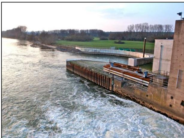
Abb. 1.18: Blick von der Wehrbrücke ins Unterwasser bei Wehrüberfall; oben rechts der Auslaufbereich des Kraftwerks.
