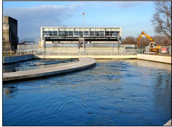
Abb. 1.1b: Wasserkraftwerk Kostheim: Einlaufbereich; im Hintergrund das Kraftwerk mit Rechenreinigungsanlage, links: Wehrpfeiler.
