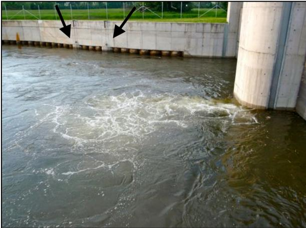
Abb. 1.6: Ausläufe Salmonidenabstieg (Pfeile) und Austritt Bypass im Mitteltrennpfeiler (Mitte rechts).
