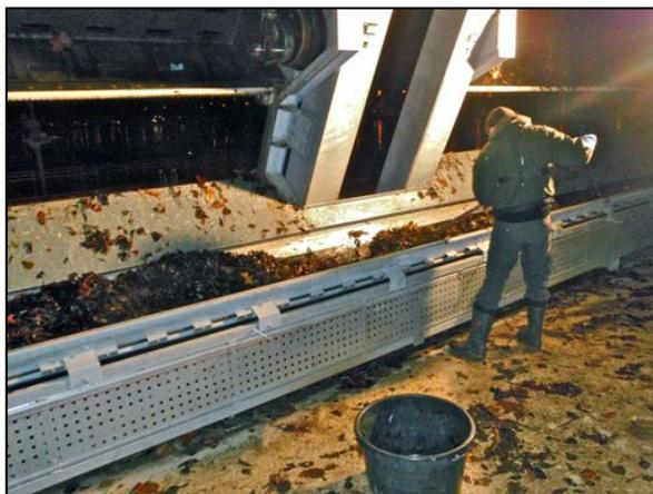
Abb. 2.23: Kontrolle des Rechenguts auf dem Förderband.
