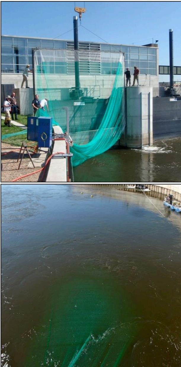
Abb. 2.12: Einbau des Hamens (oben) und Netz im Fangbetrieb (unten), beide Variante 1.
