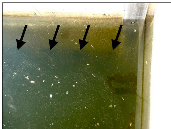
Abb. 1.5: Die Abstiegsöffnungen im Rechen (Pfeile) befinden sich rund 30 cm unter der Wasseroberfläche.
