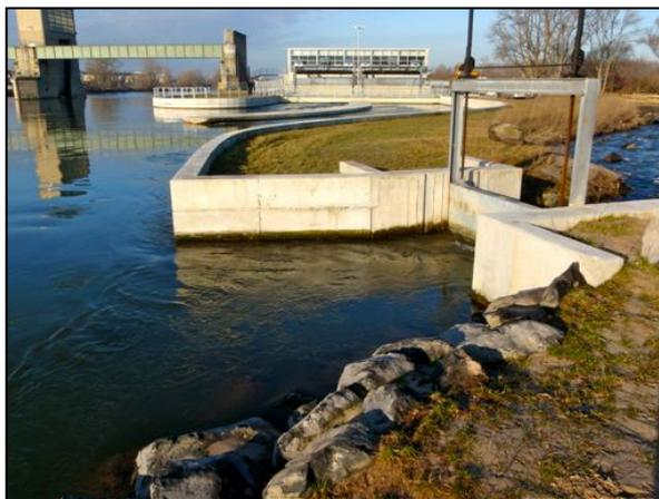
Abb. 1.11: Einlaufbauwerk und Oberwasserbereich Umgehungsgerinne.
