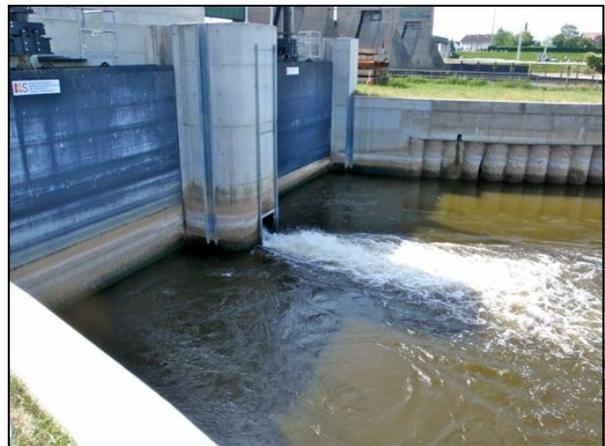
Abb. 1.8: Austrittsöffnung Bypass im Mitteltrennpfeiler bei niedrigem Unterwasserstand; die deutlich erkennbare Austrittsfahne (Bildmitte) wirkt sich potenziell als „irreführende“ Leitströmung aus.
