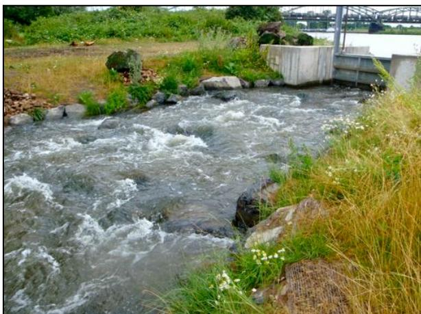
Abb. 1.10: Einlaufbereich des Umgehungsgerinnes bei geschlossenem (oben) und geöffnetem (unten) Einlaufschütz.
