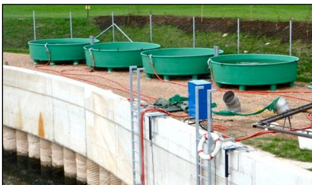
Abb. 2.27: GFK-Rundbecken zur Hälterung der Fische.
