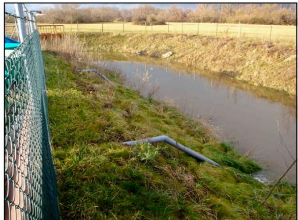
Abb. 1.15: Auslaufbereich des Umgehungsgerinnes bei niedrigem Unterwasserstand (oben) und bei Einstau in Folge hohen Unterwasserstandes (unten).
