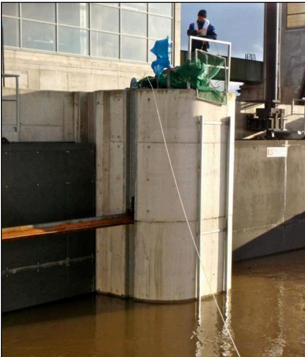
Abb. 2.19: Einsetzen des kleinen Hamens am Aalbypass.
