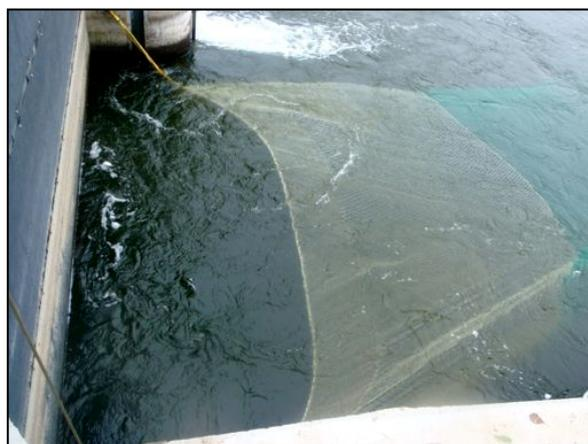
Abb. 2.16: Fangbetrieb Hamen Variante 2; zur Entlastung des Hamens schloss das Netz nicht mehr bündig ab.
